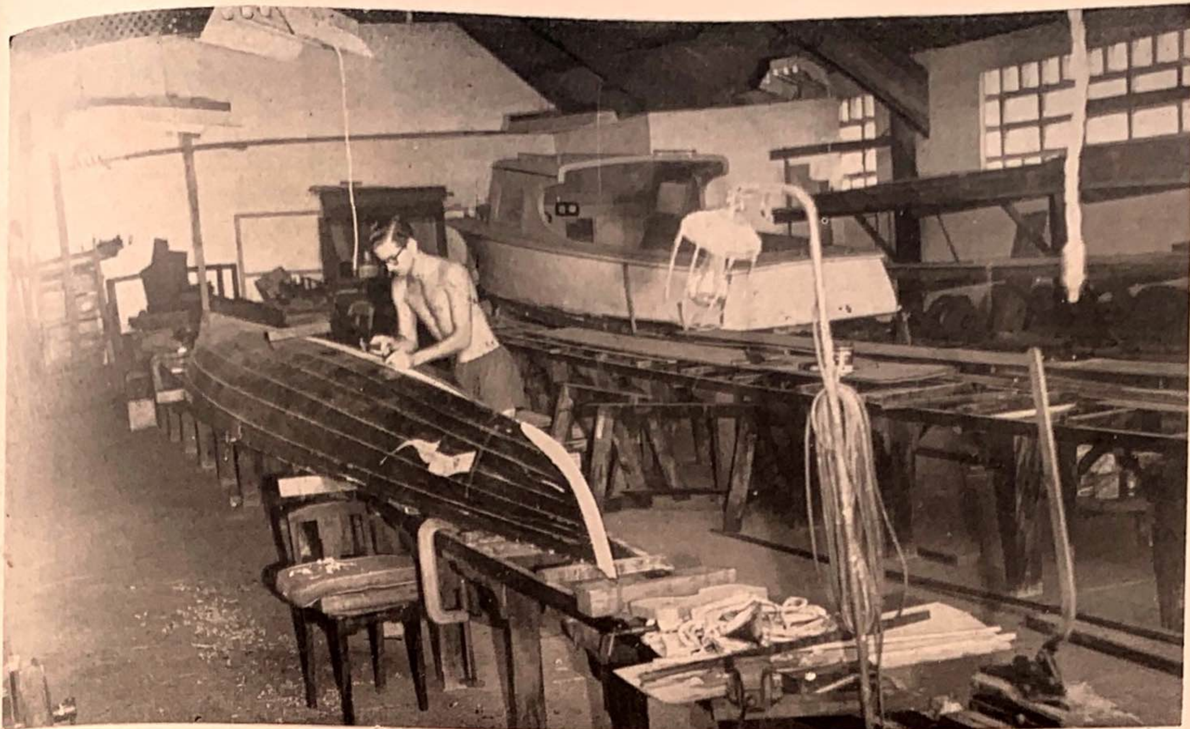
Carpintaria da garagem do Calabouço
